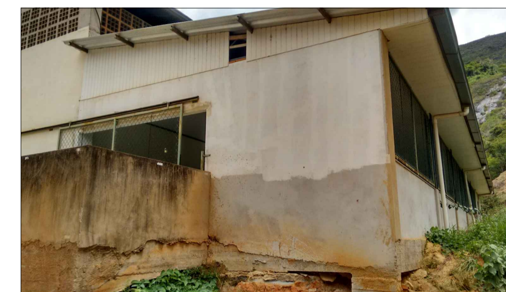
VISTA FACHADA LATERAL
