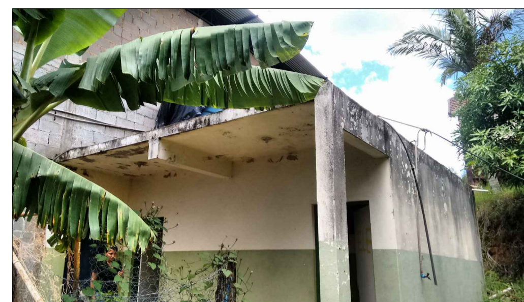
VISTA SANITÁRIOS A SEREM DEMOLIDOS
