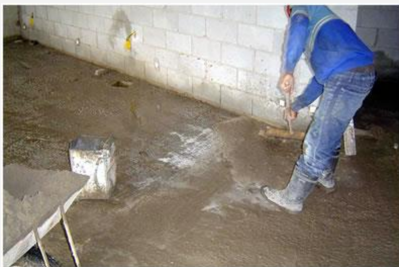
Aplicação da ponte de aderência
