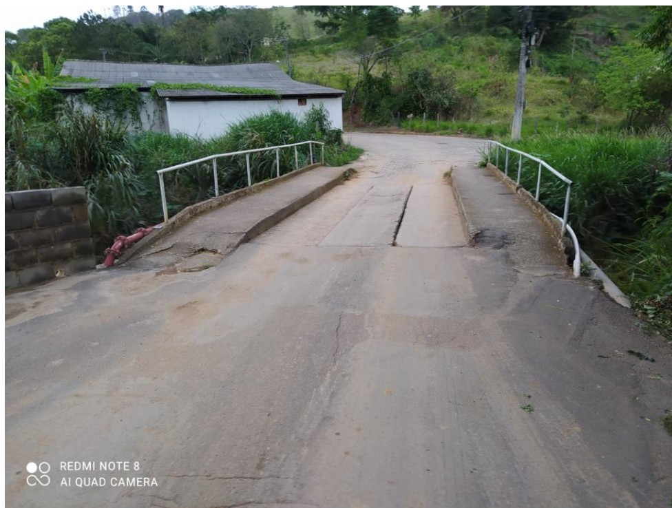
Figura 1 – Ponte Rua Moisés Belizário – vista frontal
