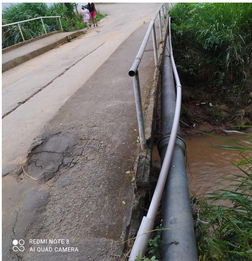
Figura 4 – Ponte Rua Moisés Belizário – vista lateral direita
