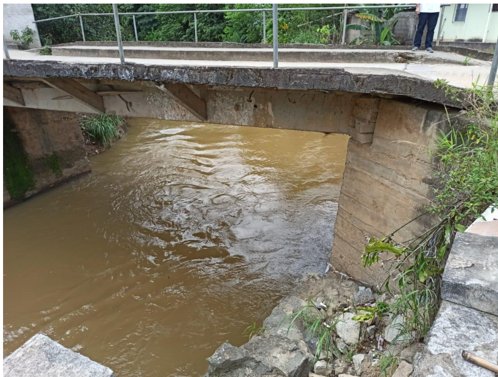
Figura 7 – Ponte Rua José Conrado de Vargas - vista lateral direita
