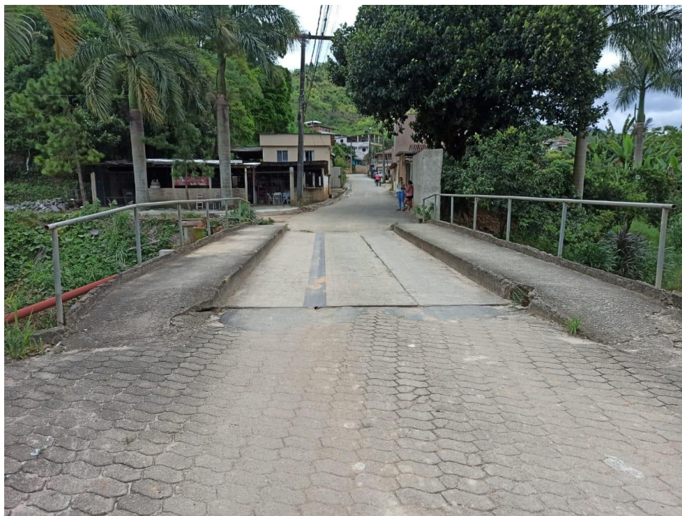
Figura 5 – Ponte Rua José Conrado de Vargas – vista frontal
