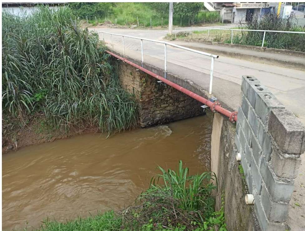
Figura 3 – Ponte Rua Moisés Belizário – vista lateral esquerda
