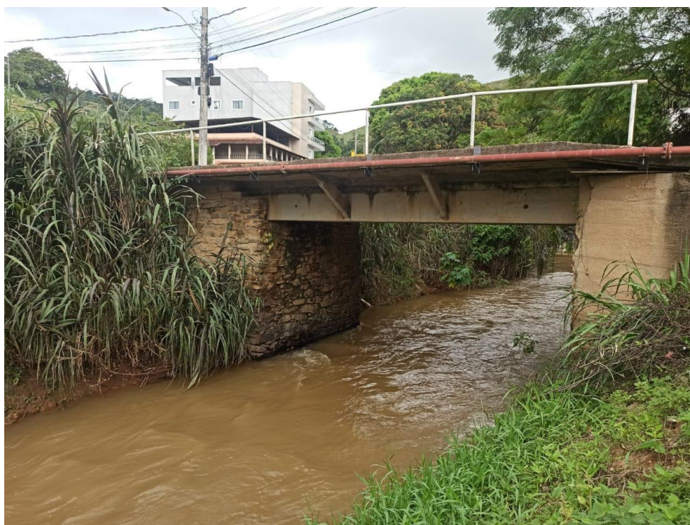
Figura 2 – Ponte Rua Moisés Belizário – vista lateral esquerda
