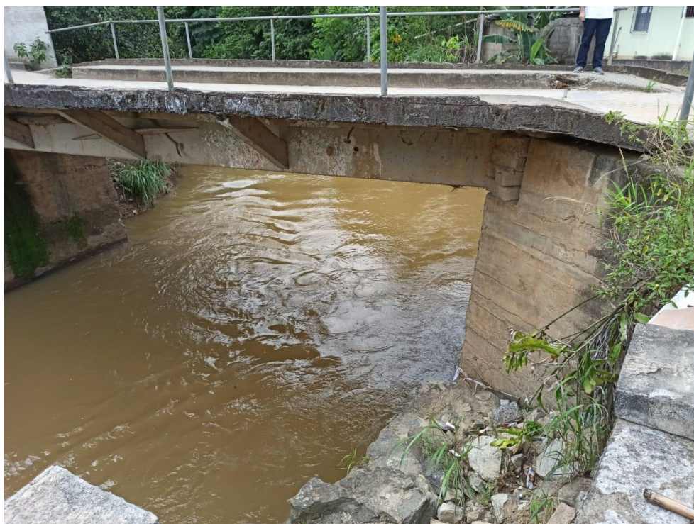
Figura 8 – Ponte Rua José Conrado de Vargas - vista lateral direita
