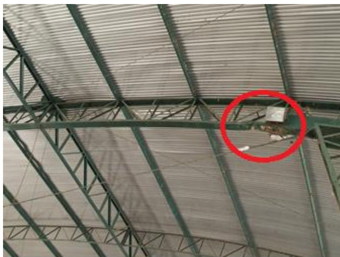
Foto 12 – Visão ampla sobre elementos com pontos de corrosão, constatando que toda a estrutura apresenta pontos de corrosão em estágio avançado.
