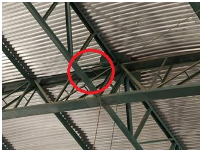
Foto 19 – Imagem aproximada para representar o banzo superior deformado.
