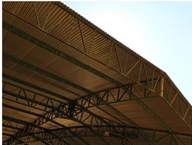
Foto 12 – Visão ampla sobre elementos com pontos de corrosão, constatando que toda a estrutura apresenta pontos de corrosão em estágio avançado.
