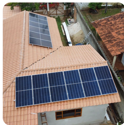
Projeto Residencial 6,48kWp - 12 Módulos Guarapari- ES
